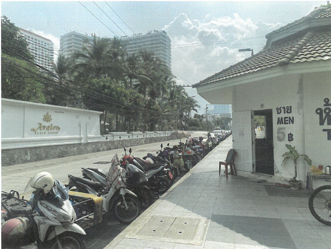
๑. ภาพถ่ายห้องน้ำสาธารณะหาดตงตาลหลังที่ ๑ (ตรงข้ามโรงแรมเอวาลอนบีช รีสอร์ท)
